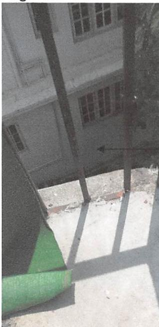
Souder un fer à béton sur toute la périphérie du garde-corps en toiture, tel que cela a déjà été fait à l'étage inférieur Weld a concrete iron around the entire periphery of the roof railing, as was already done on the lower floor
