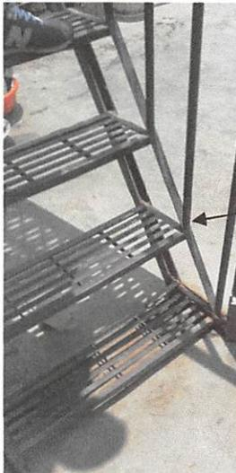
Souder des barres de renforts pour solidifier le pied support majeur de l'escalier (risque important d'effondrement) Weld reinforcement bars to solidify the major support foot of the staircase (significant risk of collapse)
