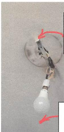
Isoler les câbles qui passent près de la réglette en métal car avec la lampe sur douille volante il y a risque d'amorçage dans le temps. /Insulate the cables which pass close to the metal strips because with the lamp on a flying socket there is a risk of ignition over time.
