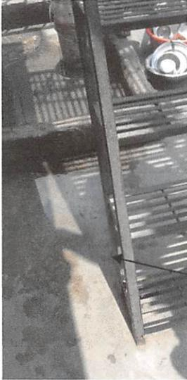
Souder des barres de renforts en repositionnant la première marche sur le support avant qu'elle ne cède. Weld reinforcement bars by repositioning the first step on the support before it gives way.
